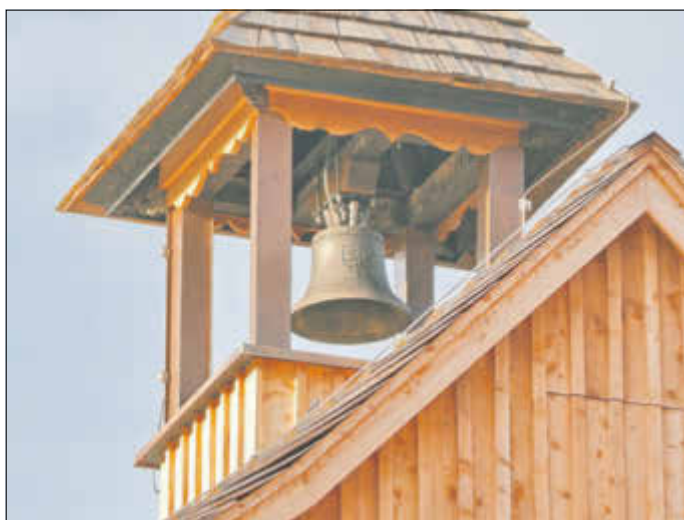
Abbildung 7 – Neue Bergglocke im Wächtertürmchen (Foto: Torsten Otto)
