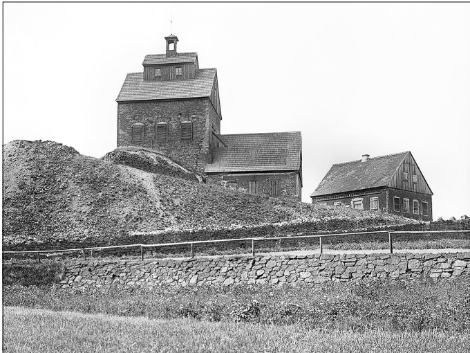
Abbildung 1 – Halde mit Treibehaus und angesetzter Scheidebank, rechts anschließend die Bergschmiede, 1909 (Foto: Paul Schulz, [10])
