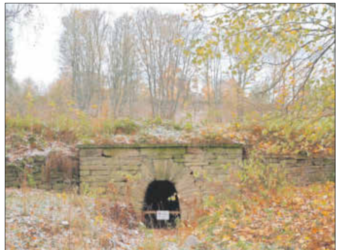
Abbildung 3 - Mundloch der Aufschlagrösche am Roten Graben, mittig im Hintergrund kann man das Treibehaus erahnen, 2022 (Foto: Torsten Otto)
